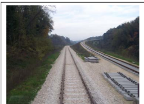
Lavori di realizzazione linea ferroviaria San Vito Chetino - Lanciano
